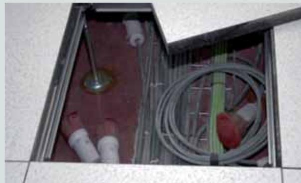
↑ **Figura 11.38.** Detalle de canalización bajo suelo técnico.
