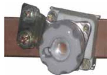
↑ Figura 7.13. Detalle de conexión de base portafusibles Diazed sobre pletina en un embarrado de centralización de contadores.
