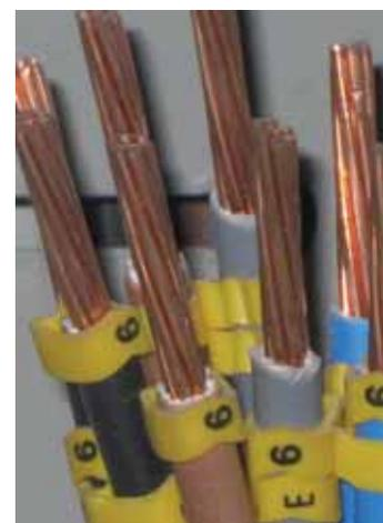
↑ Figura 5.25. Anillas para la identificación de conductores.
