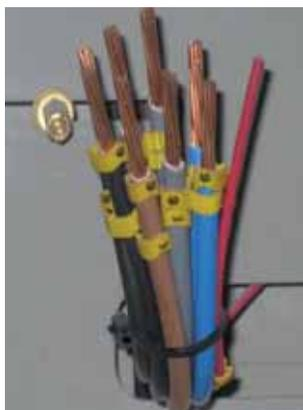
↑ Figura 8.13. Conductores para la conexión de un contador.
