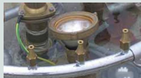
↑ **Figura 11.34.** Detalle de conexión de la red equipotencial de tierra y acometida a las envolventes en una fuente.
