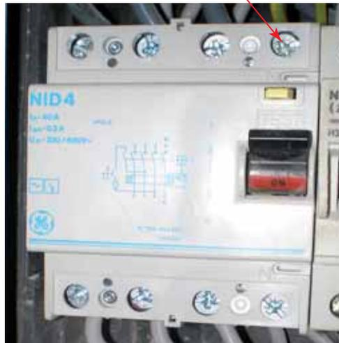
↑ **Figura 12.14.** Dado que no existen diferenciales tripolares, en líneas trifásicas sin neutro, se conecta el conductor de protección en el borne de neutro solamente para que funcione el pulsador de test.
