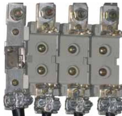
↑ **Figura 7.16.** Bases portafusibles NH00 de 160 A más seccionador para el conductor neutro.
