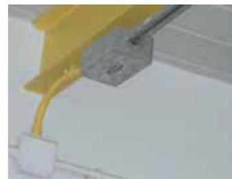
↑ Figura 10.15. Canalización con pletinas conductoras.
