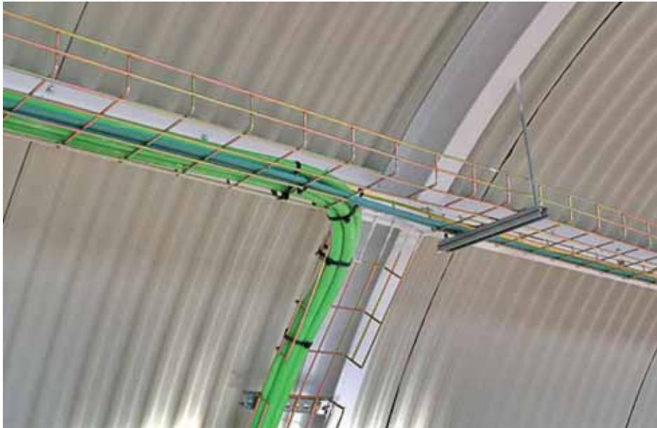
↑ Figura 6.23. Detalle de instalación de bandejas de rejilla.
