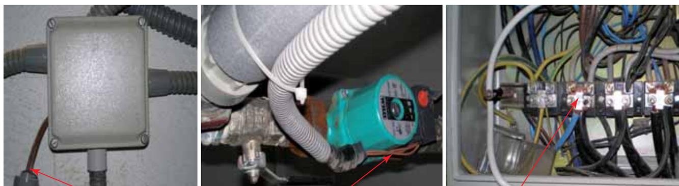
Racor suelto: los cables quedan sin protección mecánica y no hay estanqueidad.
