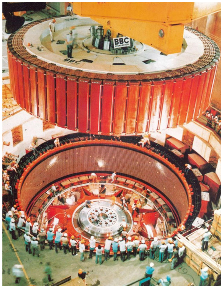
Fig. 26: Hidroalternador síncrono trifásico de la central de Itaipú de 824 MVA, 90 r.p.m., 60 Hz (Fuente: Revista ABB, nº 1, 1992).
