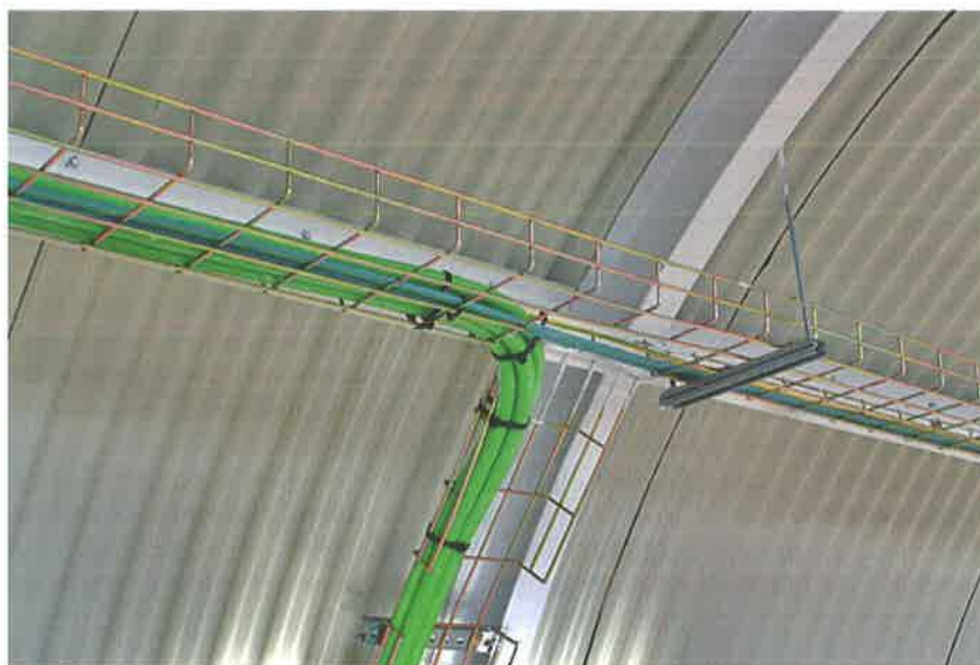
Figura 6.22. Detalle de instalación de bandejas de rejilla.
