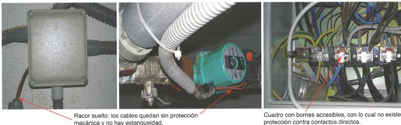
Figura 12.1. Anomalías que deben ser detectadas en la verificación por examen.
