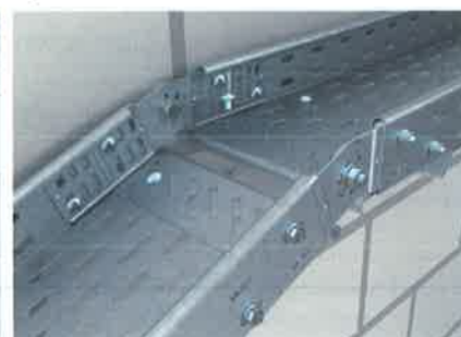
Figura 6.27. Montaje en bandejas perforadas (OBO Bettermann).
