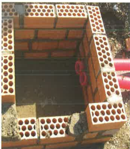
Figura 6.34. Obra civil de construcción de una arqueta para canalizaciones enterradas.
