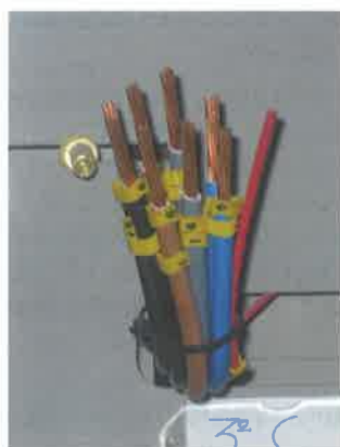
Figura 8.18. Conductores para la conexión de un contador.
