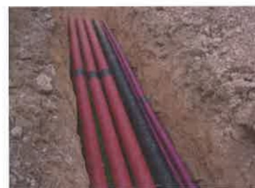
Figura 5.2. Canalizaciones enterradas.
