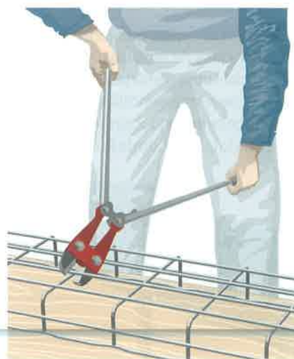
Figura 6.24. Proceso de corte de bandeja de rejilla.
