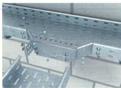
Figura 6.25. Carga de trabajo en bandejas perforadas de 60 mm de ala (Obo Bettermann).
